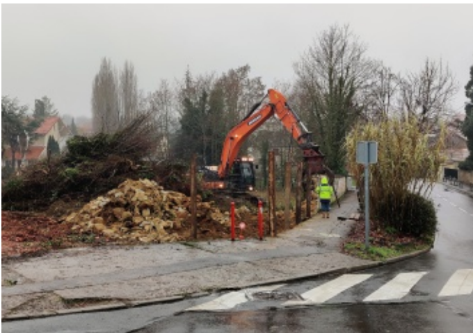
Les travaux de la ferme Benoît dans le Bourg
